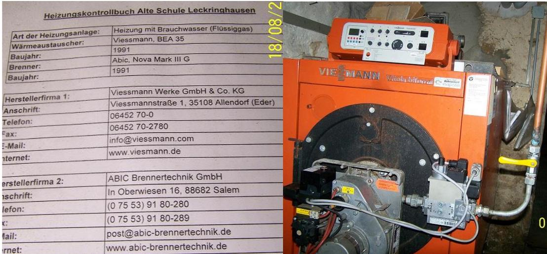
Abbildung 2 Heizerzeuger Alter Kessel aus 1991 Viessmann Vitola ohne WW-Bereitung, Leitungen im unbeheizten Bereich gedämmt, kein WW-Verteilungssystem im Haus, WW-Zubereitung im EG und OG per Durchlauferhitzer
